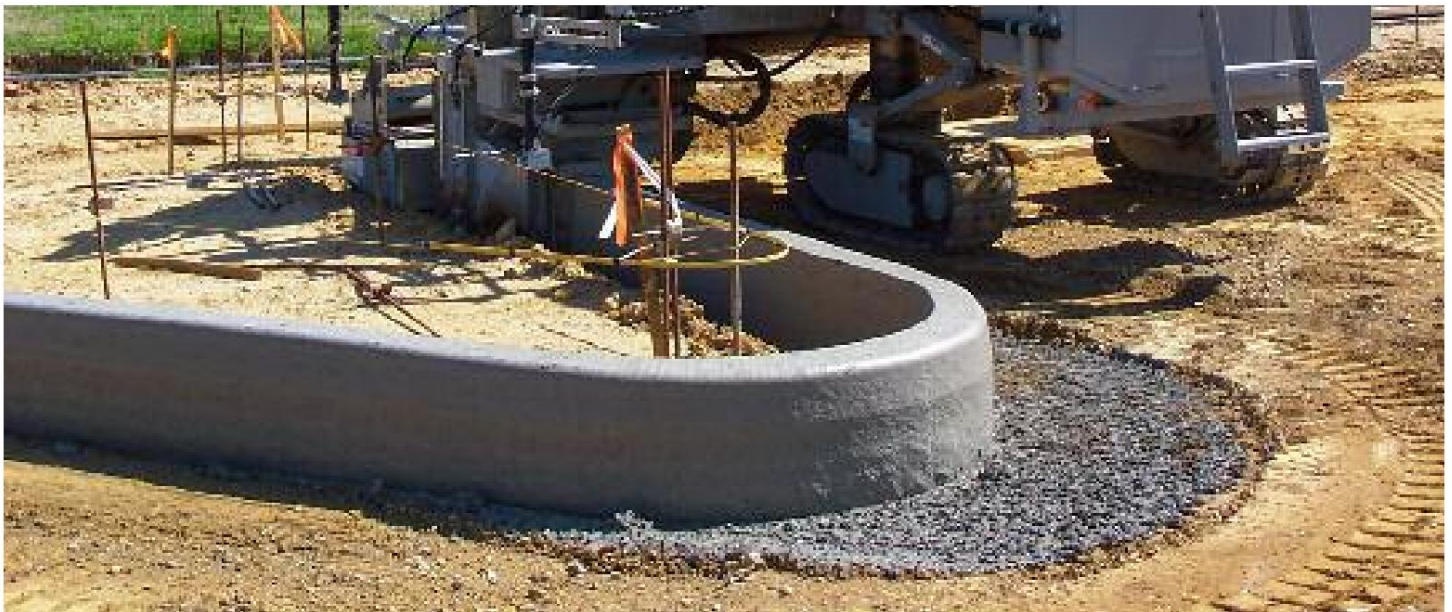
La capacidad de radio estrecho de la máquina elimina horas de formación manual y produce un producto de mayor calidad.
