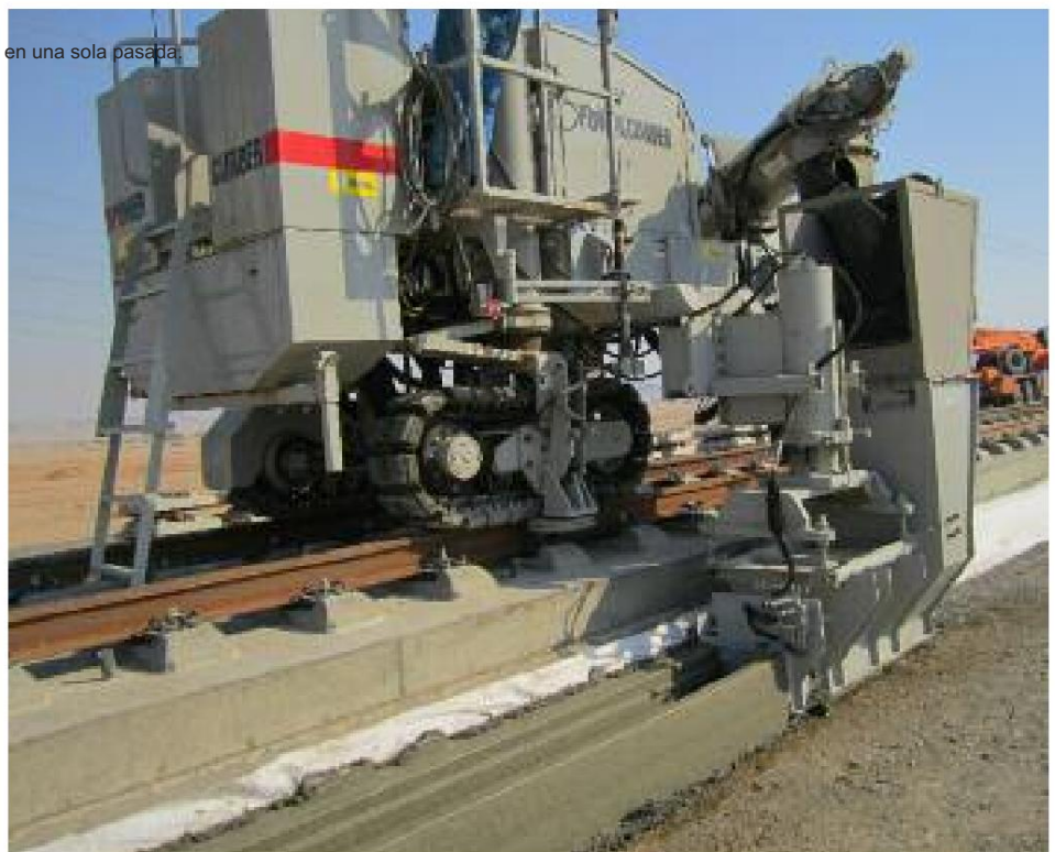
Aplicación ferroviaria de alta velocidad en Arabia Saudita que utiliza accesorios ferroviarios personalizados para verter un canal de servicios públicos.
