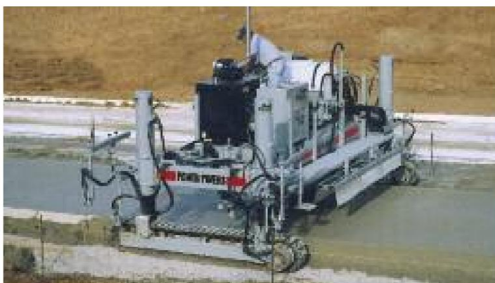
Máquina de texturizado y curado Power Pavers TC-2700
