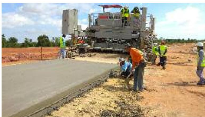
s Power Curbers 7700 Máquina de encofrado deslizante multiusos para pavimentación
