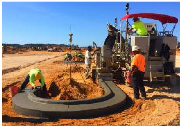
Vertido de bordillos y cunetas con control 3-D (sin cuerdas).
