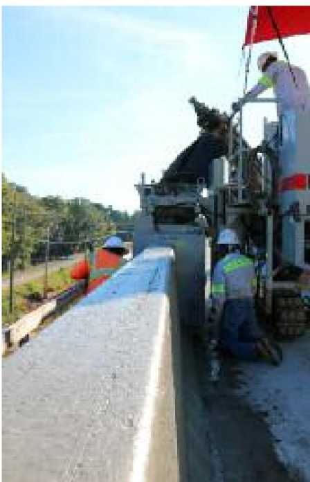
Primer plano del parapeto del puente
