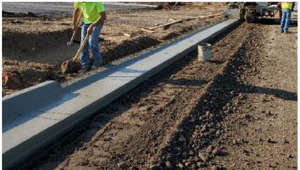
Las cuchillas para entradas de vehículos reducen el desperdicio de material y mano de obra. Se requiere un poco de acabado manual.
