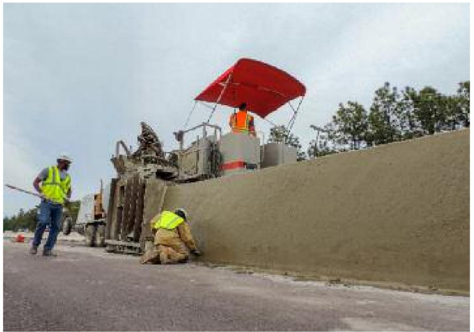
Barrera variable, hasta 58" (1,47m) de altura.
