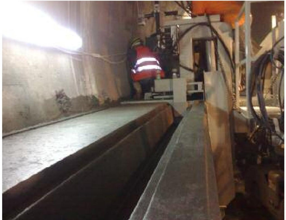
Plataforma y estructura de pared vertidas a lo largo de la pared de un túnel en Turquía: el molde es ajustable en altura y ancho para adaptarse a diferentes diámetros del túnel.
