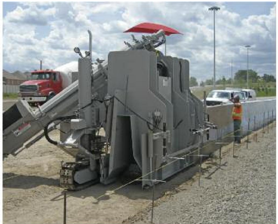
Paquete MAX que vierte una gran pared de barrera variable.
