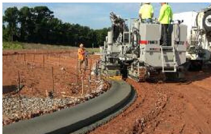
El poste trasero del modelo 5700-D-MAX se puede devolver a su posición estándar para verter bordillos y cunetas.
