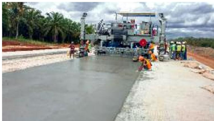
Pavimentadora de encofrado deslizante SF-2404 de 4 orugas de tamaño completo de s Power Pavers
