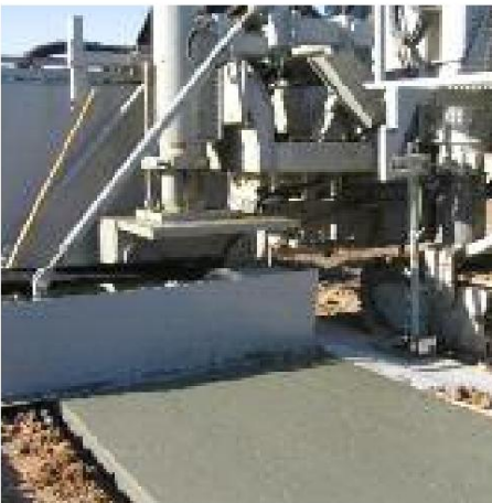
Acera adyacente a la parte trasera del bordillo. Detección fuera de la acera.
