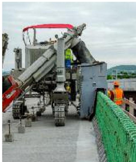
Vertido de barrera sobre jaula de varilla de refuerzo.
