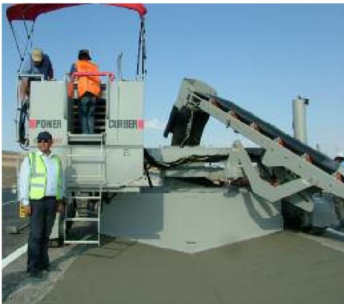
Revestimiento de zanja en Turquía, de 12,5' (3,8 m) de ancho y 2' (0,6 m) de profundidad, adyacente al pavimento en ambos lados. (Se muestra con transportador de banda personalizado)
