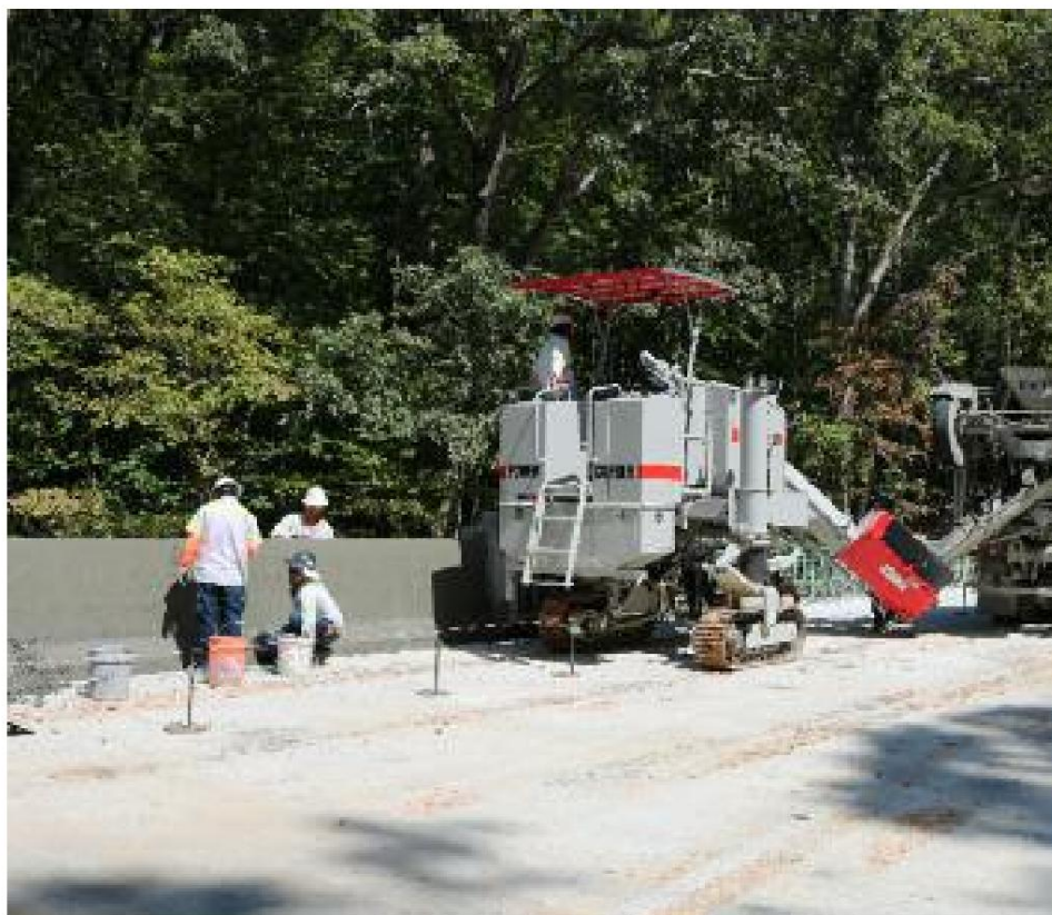
5700-D-MAX Parapeto de puente de hormigón sobre refuerzo. Incluye cubierta opcional.
