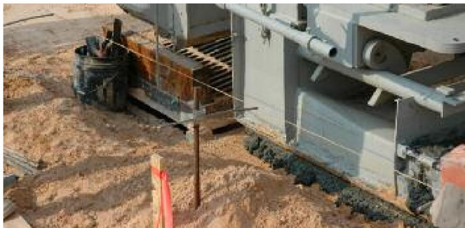
Recortadora levantada sobre el sumidero para verter el bordillo lo más cerca posible.
