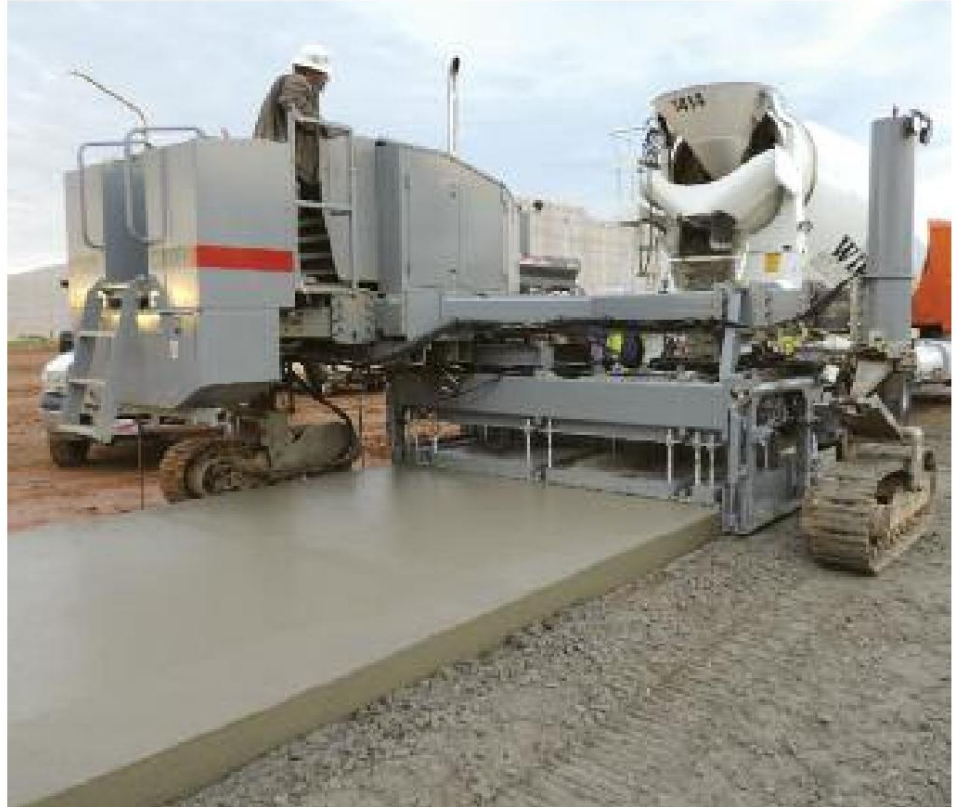
Pavimento de vertido central de 10' (3 m) de ancho. El hormigón se vierte directamente en una tolva ubicada en la parte delantera del molde de pavimentación.
