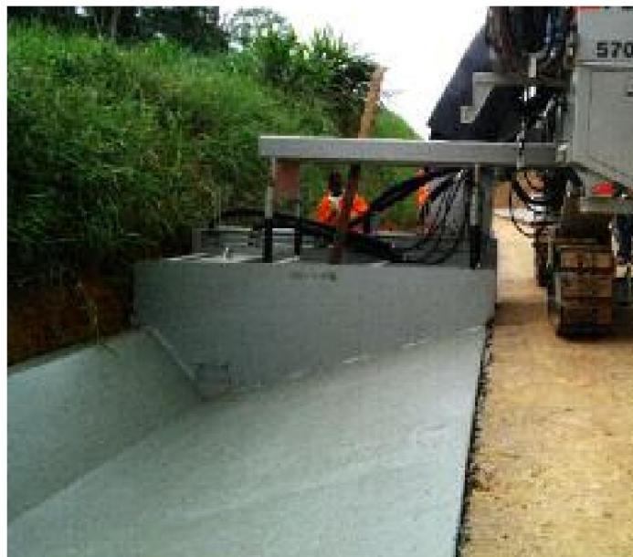
Zanja en forma de V en Guinea Ecuatorial, de 7' (2,2 m) de ancho y 18" (0,45 m) de profundidad, vertida adyacente al pavimento.
