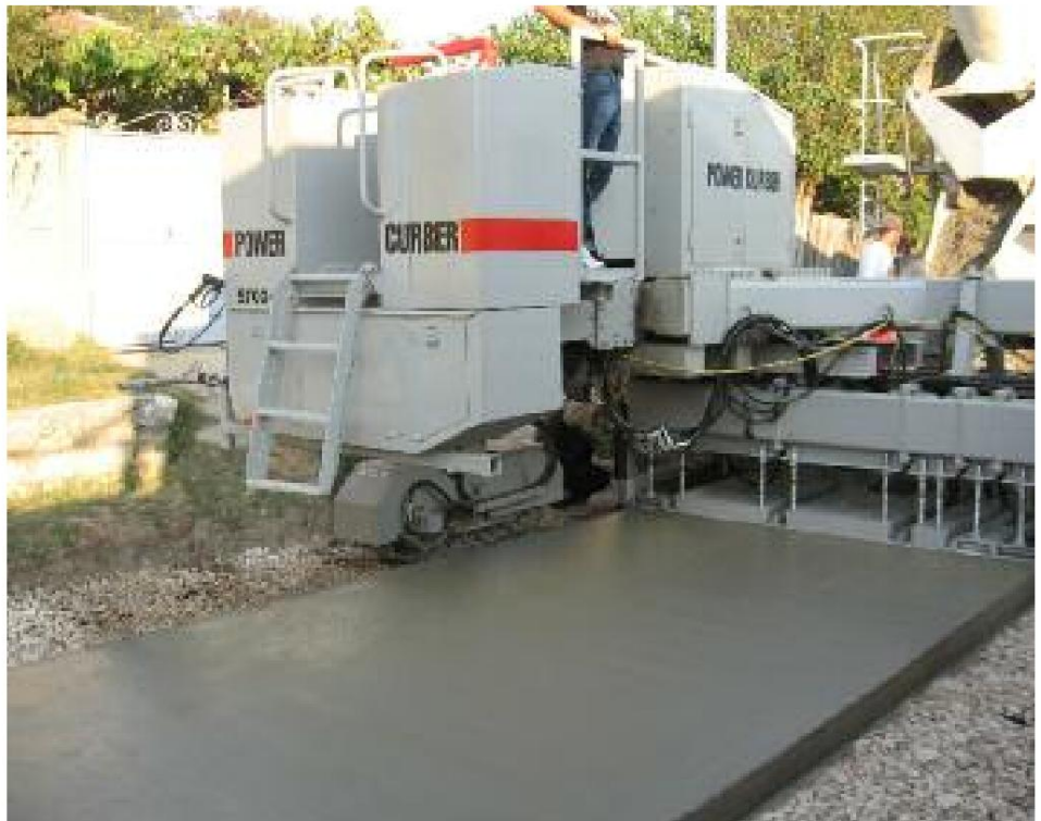
Pavimento de 10' (3 m) de ancho. El adoquín de vertido central es seccional para distintos anchos de pavimentación.
