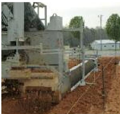
Recortadora de zanjas a medida y base para gallinero.
