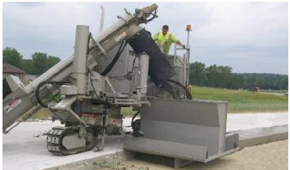
Adición de delantal sobre acero, con detección sobre pavimento existente.
