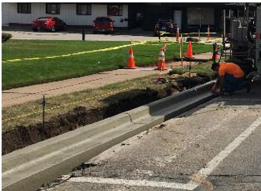
Bordillos y cunetas en una aplicación de rehabilitación
